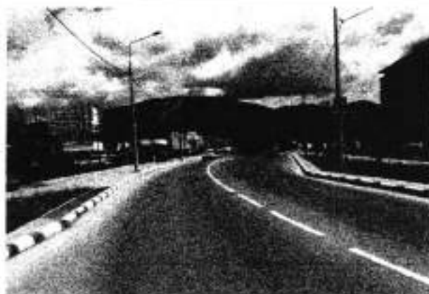
Реконструкция дорожного покрытия
